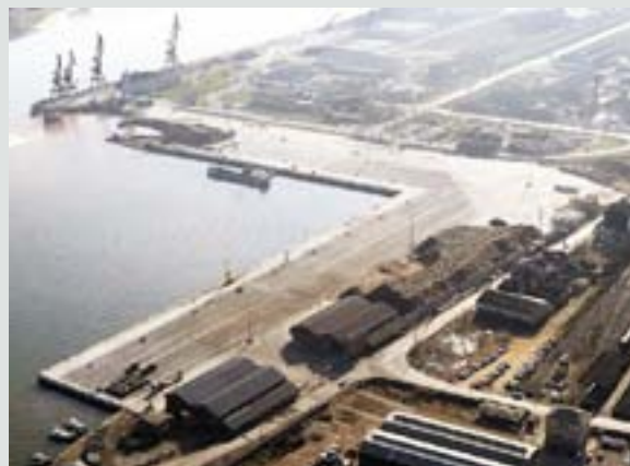
Situazione dopo i lavori
