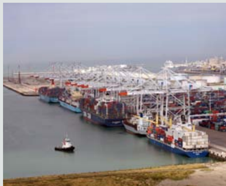
Lavori di costruzione e operazioni nella prima fase di «Port 2000» © Autorité portuaire du Havre
